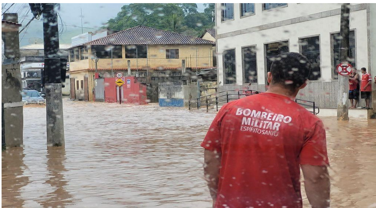
Figura 5.3 – Ocorrência de inundação na cidade de Mimoso do Sul em dezembro de 2008.
