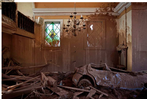
Carro, arrastado para dentro de uma igreja pelos deslizamentos de terra. Nova Friburgo, 21 de janeiro de 2011.
